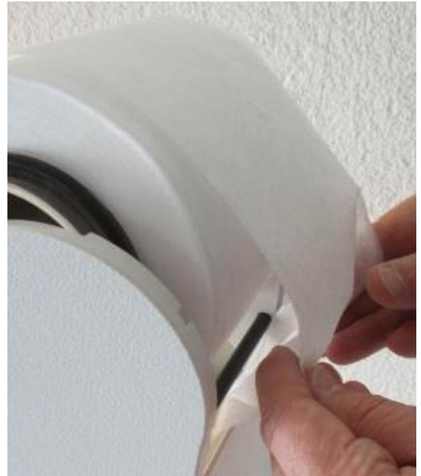
**Stellen Sie sicher, dass die Rolle vollständig eingelegt ist, und fädeln Sie dann das Vlies zwischen Strebe und Gehäuse ein**
