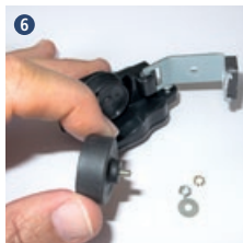
De membraan wordt van de magneetbeugel losgemaakt
